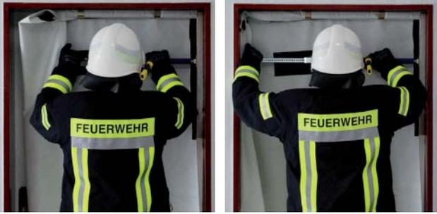
Deslice la parte del marco móvil del bloqueador de humo hacia la izquierda para ajustar el bloqueador de humo al ancho de la puerta.
